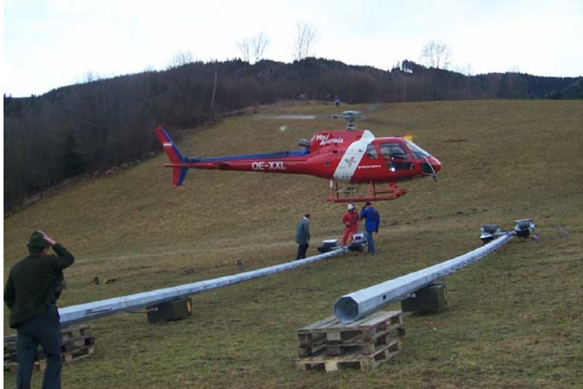
Obr. č. 4 – Transport osvětlovacích stožárů pomocí vrtulníku.
